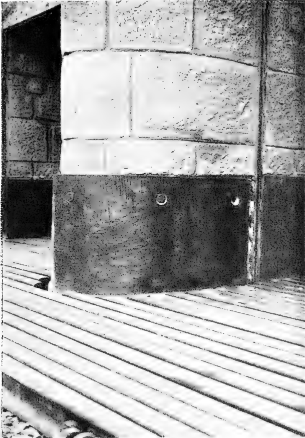
Fig. 6. — Piso metálico y blindaje de paredes del pilar
