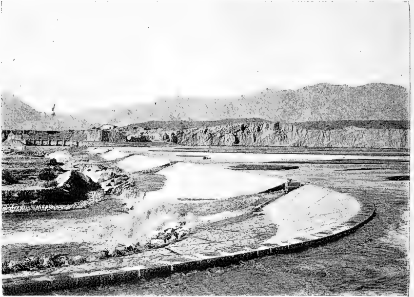
Fig. 1.— Disposición general del muro sumergible
