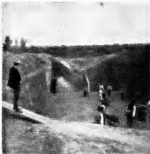
Salto de 9,50 metros en Alderetes
