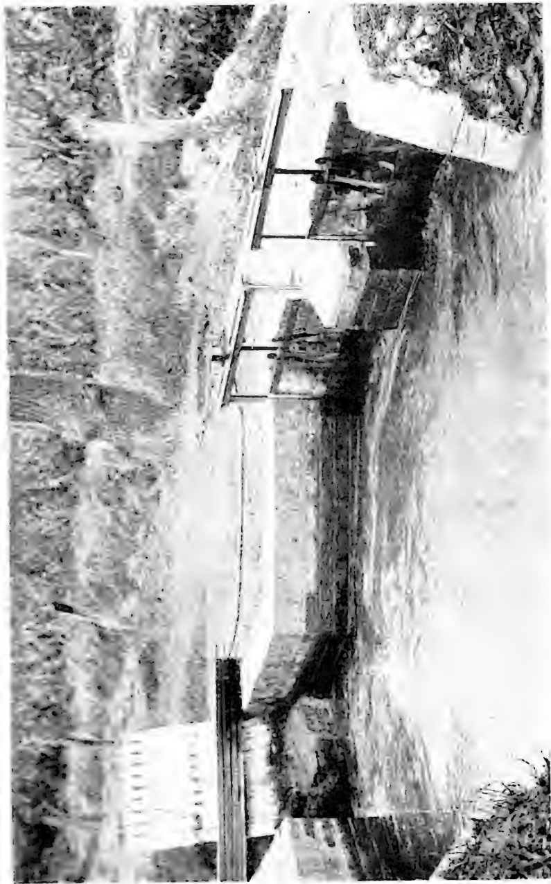
TIPO DE VERTEDEROS Á PAREDES LATERALES MOVIBLES
