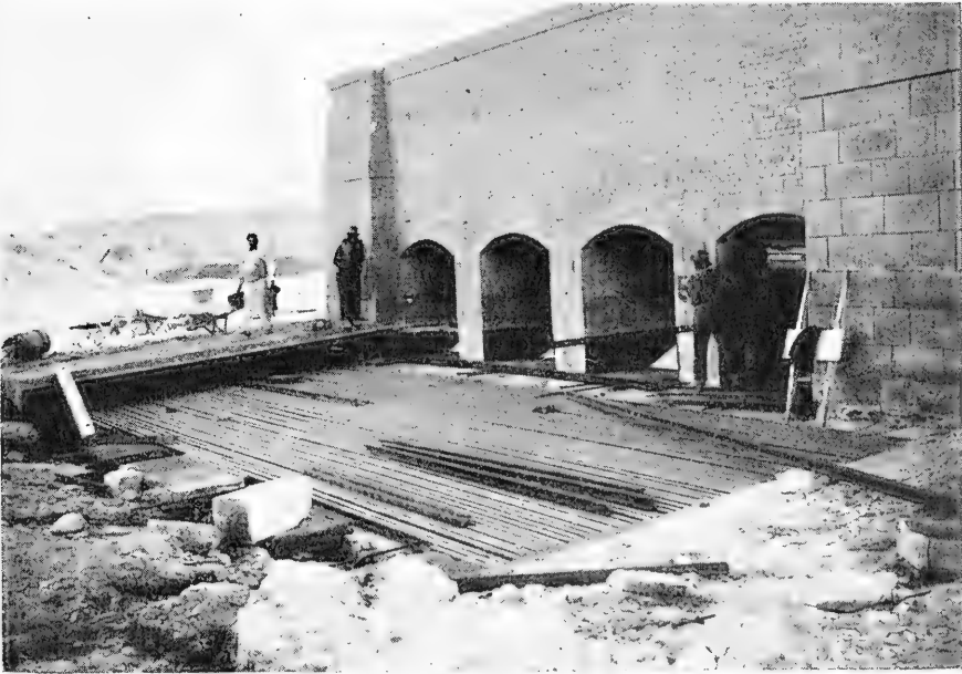
Fig. 4. — Piso metálico y blindaje de paredes del descargador principal
