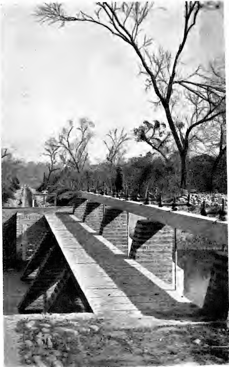
CANAL DE DESCARGA DEL DESARENADOR N.º 1
