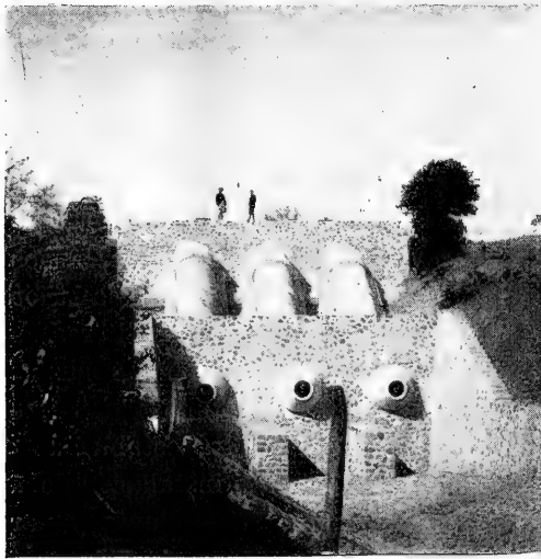
Salto de 8,30 metros en la toma
