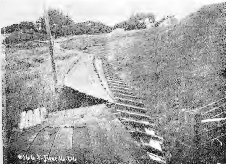
Fig. 17.—Daños a las armazones de las cañerías de San Andres
