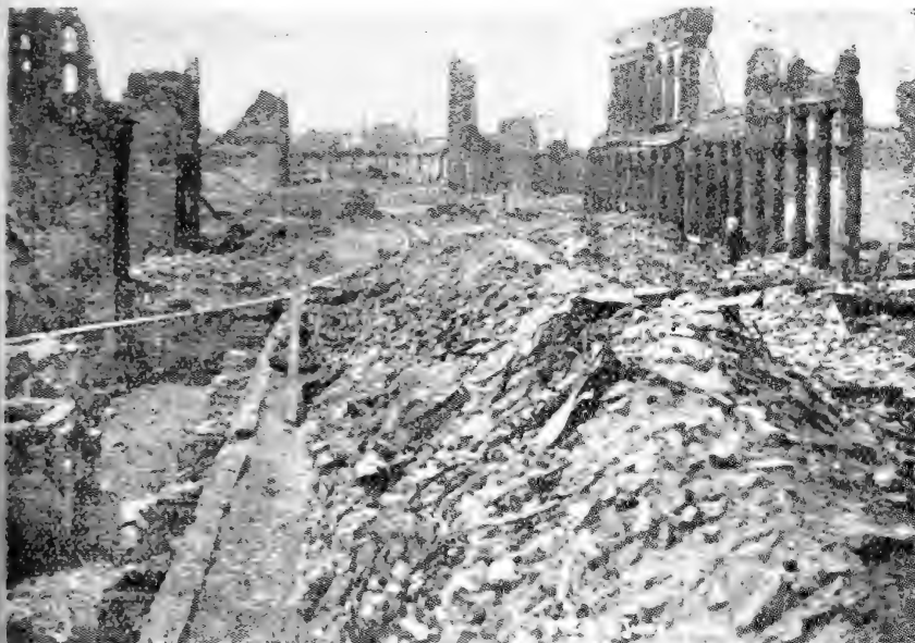
Fig. 29. -- Montón de escombros en la calle de la Batería
