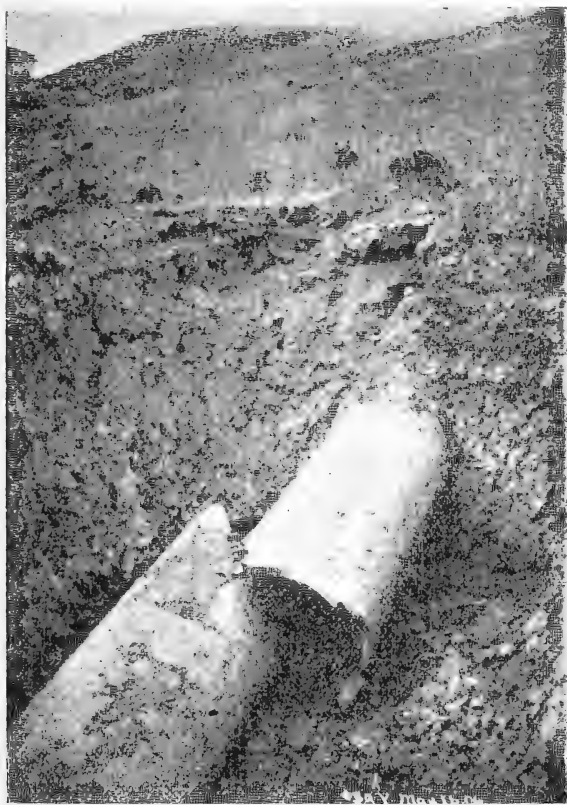
Fig. 22.—Movimiento de telescopiamiento con traslación lateral i aplastamiento
