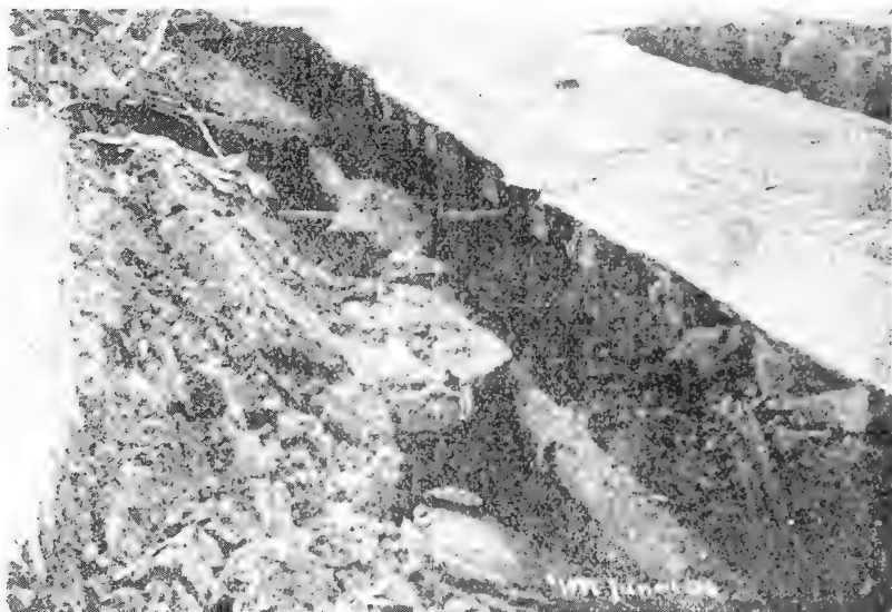
Fig. 23.—Hundimiento de cada lado de la vía de una tranvía (Calle décimo cuarta, al este de la calle de Valencia)
