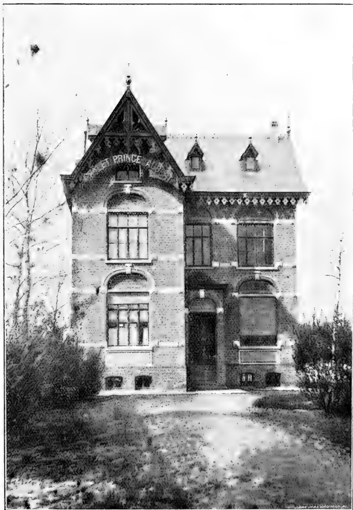
Fig. 3. — Station biologique d'Overmeire, façade Nord-Est.
