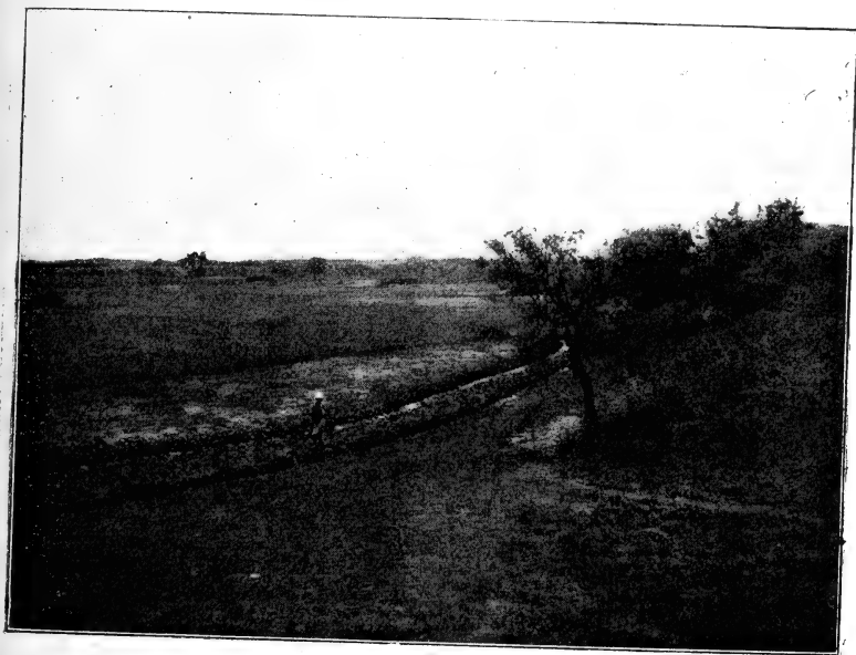
Fig. 11. — Drainage efficace d'un sol marécageux par deux sillons tracés à la charrue (à Mondovi).
