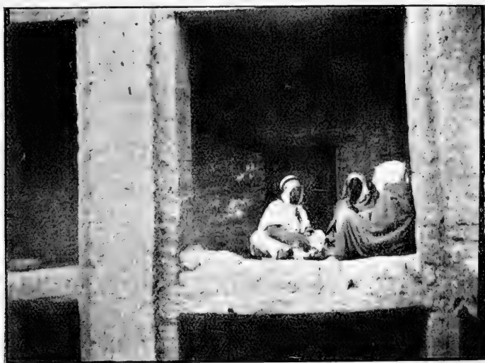
Fig. 10. — Premier étage d'une maison de Beni-Ounif.
