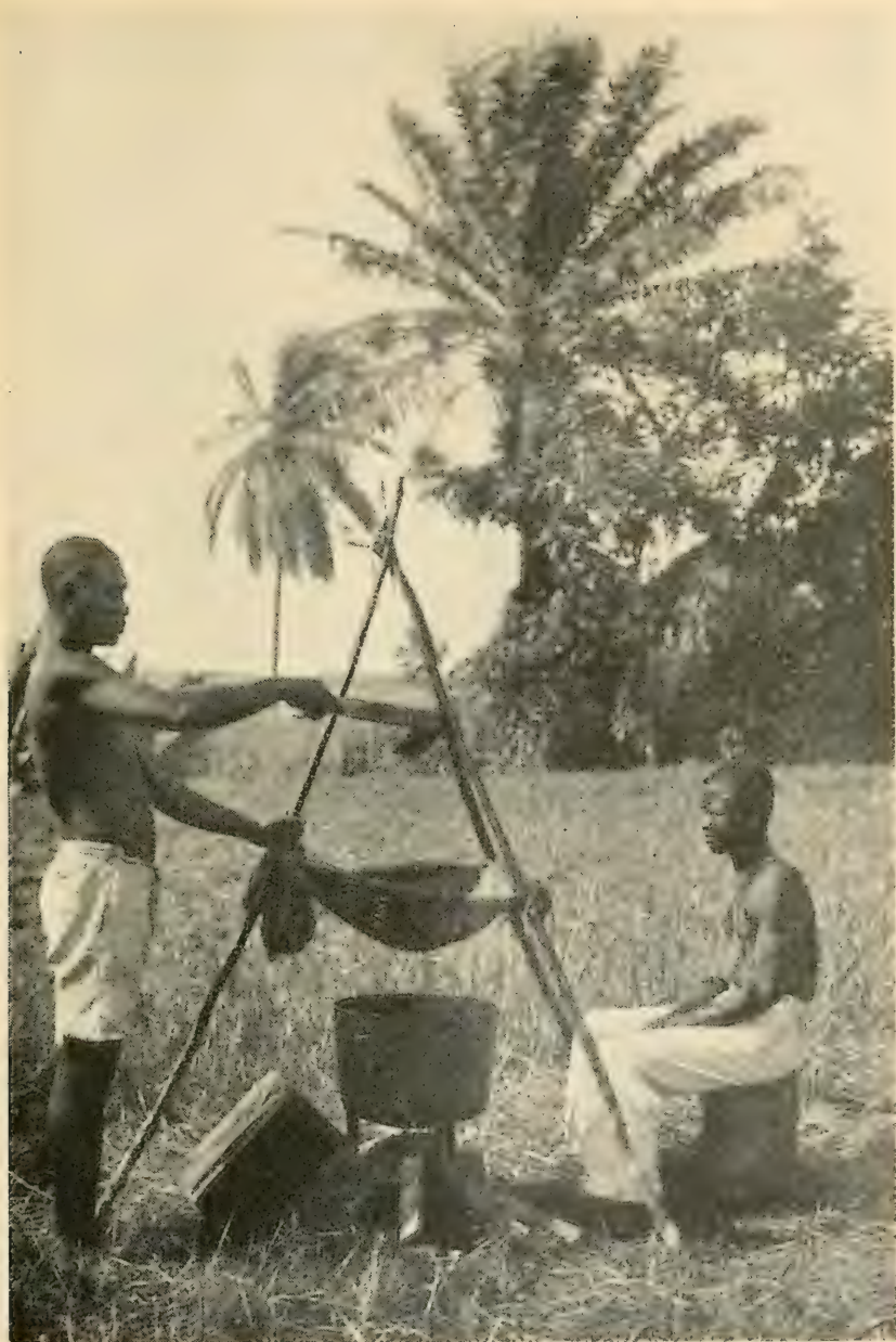
PL. I. — La décoloration de l'huile de palme par l'indigène, suivant le procédé Guichard et Aubert.
