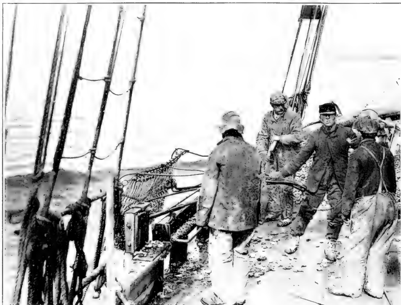
FIG. 1.—LOWERING THE DREDGE.
