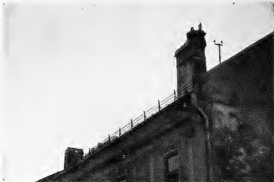
21. ábra. A domború kéményvédőn épült gólyafészek Stork's nest built on the convex chimney-top Photo: Jurán, — Hniedzne—Gnézda, 1954
