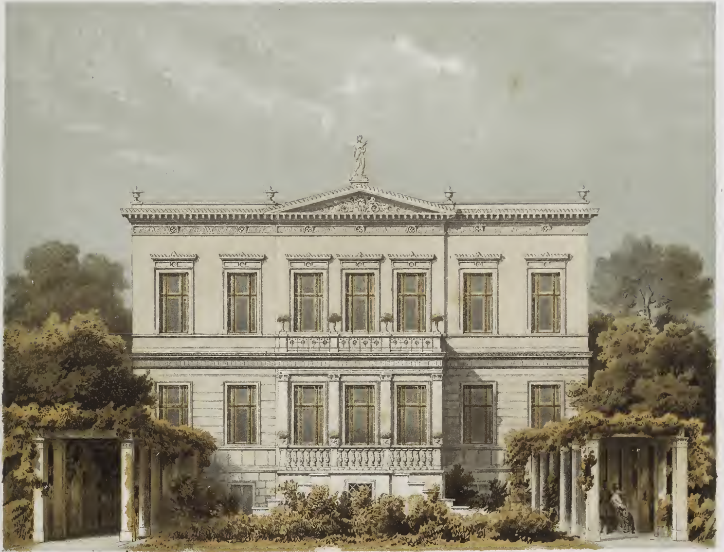
Wohnhaus Potsdamer Strasse No 10 in Berlin.
