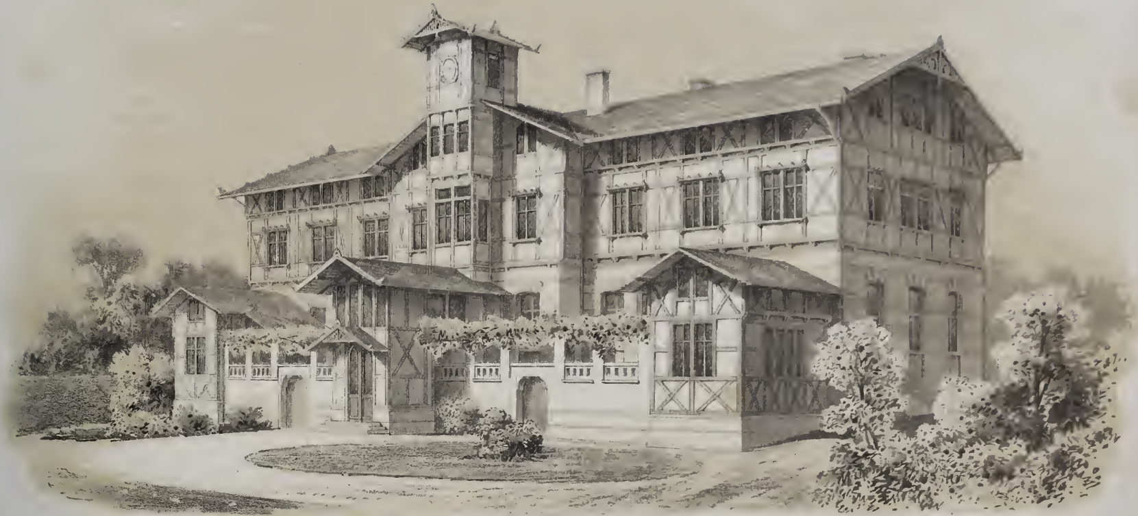
Bahnhofsgebäude in Sonneberg.
