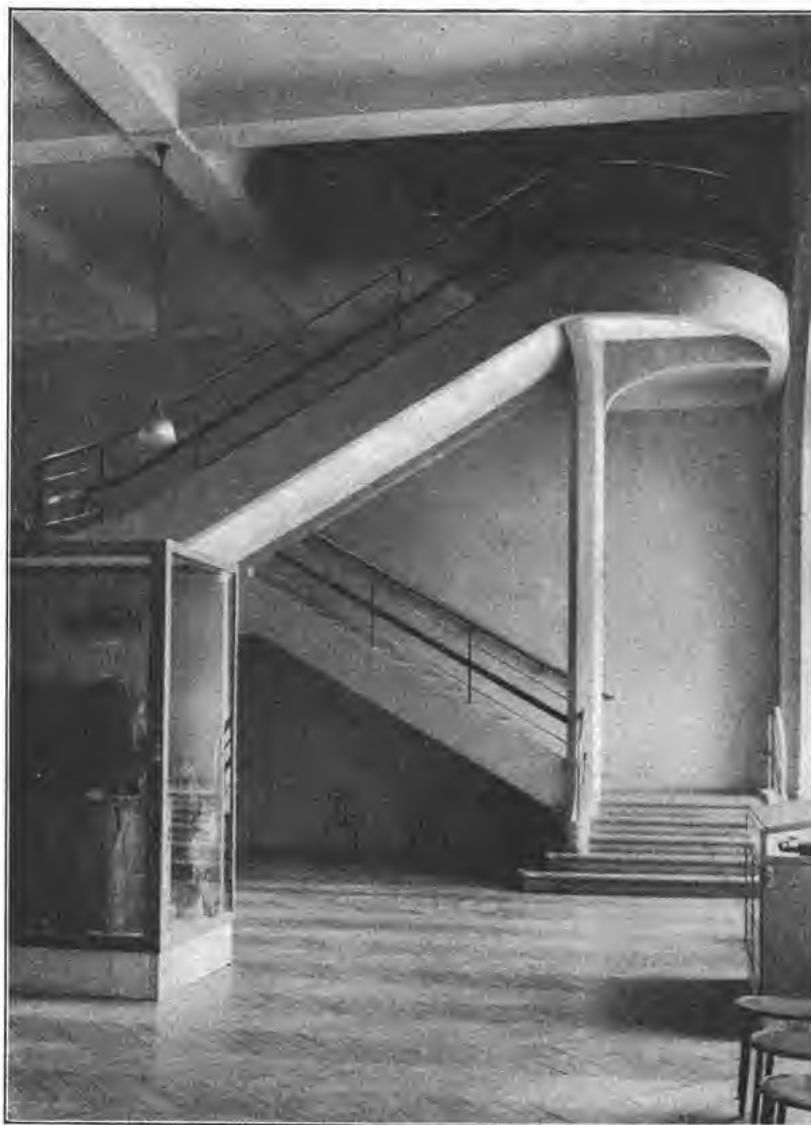
Fig. 1. — Escalier en béton armé, construit en 1932 pour passer de la Salle d'Afrique blanche à la Salle d'Europe.
