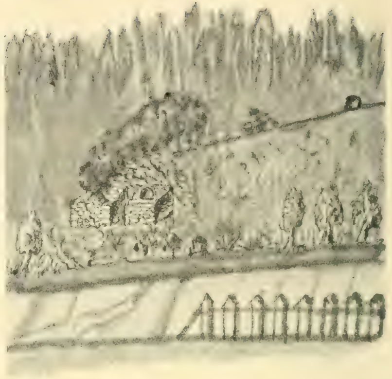
Fig. 29. Die Kalköfen bei Oelberg im Jahre 1876. Rechts oben der Stollen.]
