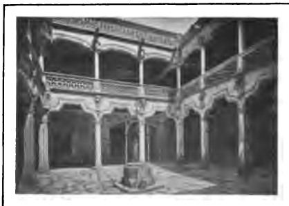
FIG. 415.—SALAMANCA. CASA DE LAS CONCHAS. PATIO.
