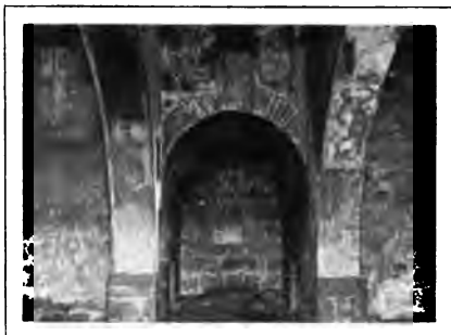
FIG. 68.—KOSÉÎR AMRA. PRINCIPAL HALL. (Comp. vaults of Kasr Kharâneh, Fig. 25, and Tag-è Ivan, Fig. 29.) (Phot. Rev. Père Savignac.)
