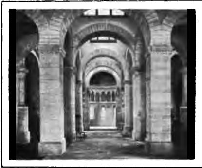
FIG. 188.—GERMGNY-DES-PRÉS. CHURCH. NAVE AISLES, AND APSE AFTER RESTORATION. ( Phot. Monuments historiques. )
