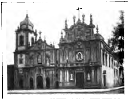
FIG. 662.—Oporto. CHURCHES DOS EXTINGTOS CARMELITAS AND DO CARMO. (Author's Phot.)
