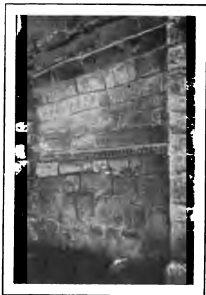
FIG. 130.—BAÑOS. SAN JUAN. EPISTLE SIDE.
