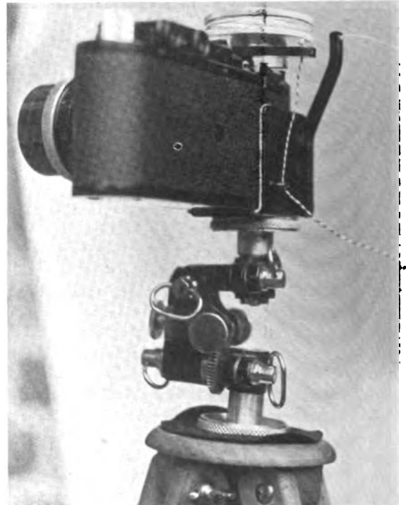
Die sehr hübsche Einrichtung für Fernauslösung und Fernaufzug, mit der selbst die scheuesten Tiere sicher photographiert werden können
