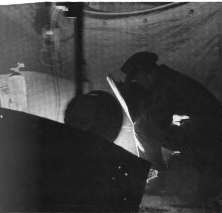
Hrch. Wimmersperg. Ausbesserung der Straßenbahnschienen durch einen Elektroschweißer
