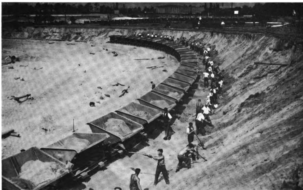
Ein Bild der Arbeit. Die olympische Kampfbahn entsteht in Berlin
