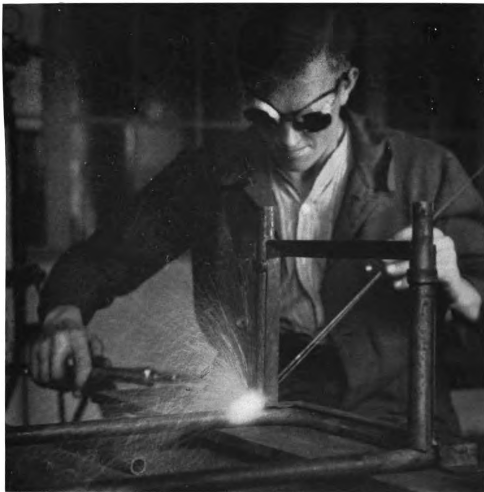
„Schweißen eines Sprühkranzes“
