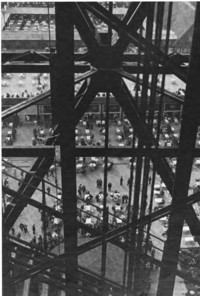
Blick durch das Massiv des Funkturms
