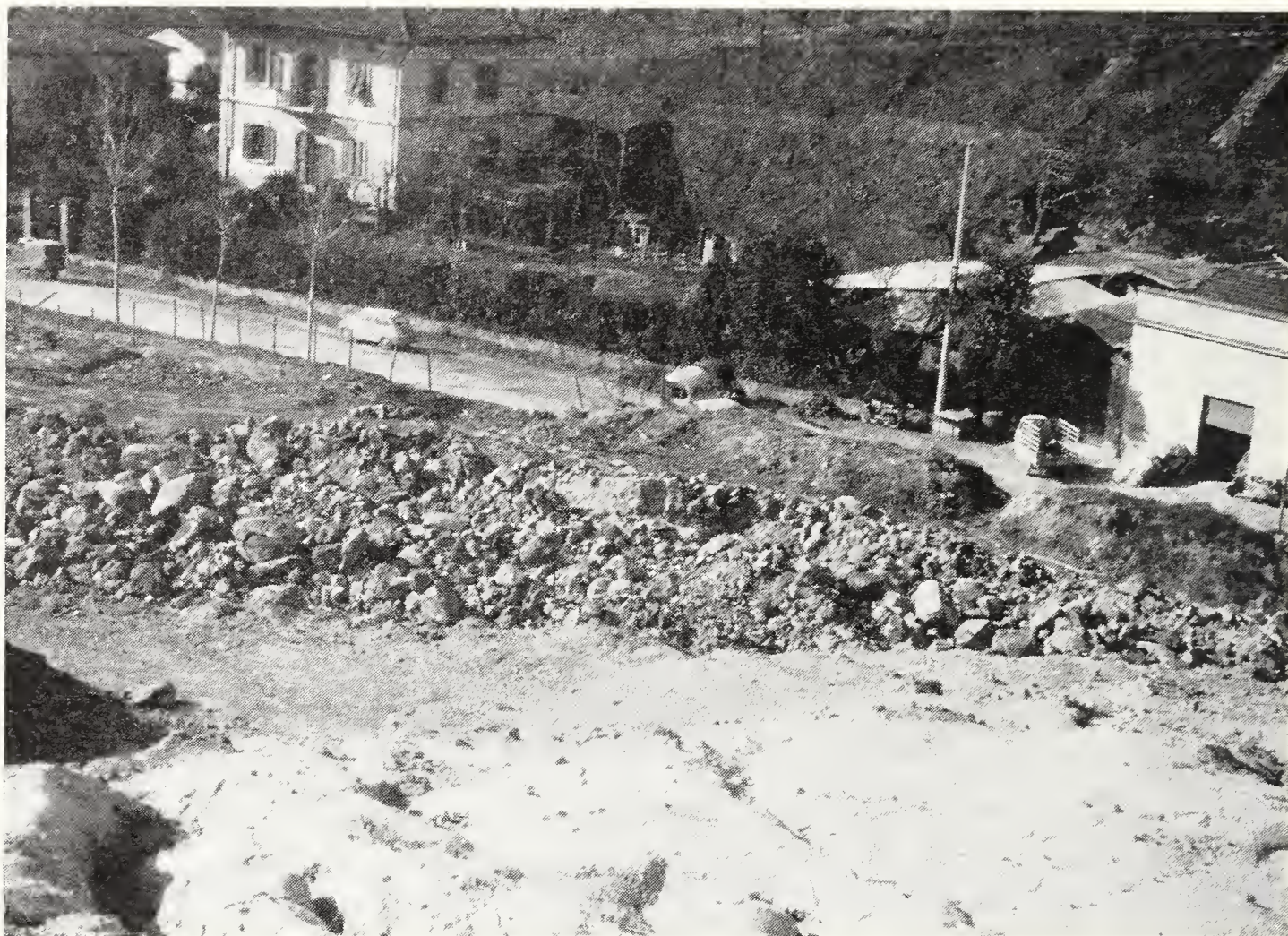
Fig. 4. — Cava Teglia (Borgo a Buggiano). Ciottolami e blocchi di macigno estratti dalla cava. Si notino, in confronto alle automobili, le loro notevoli dimensioni. In primo piano affiorano le argille di base.
