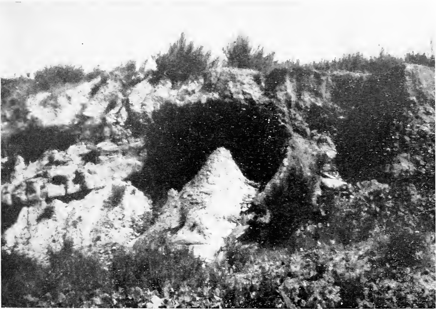
Fig. 13. — Collina di Pòrcari. Banconi di sabbie e ghiaie soprastanti le argille. Al contatto, l'erosione assume caratteri selettivi, specialmente a spese delle argille che vengono profondamente incise.
