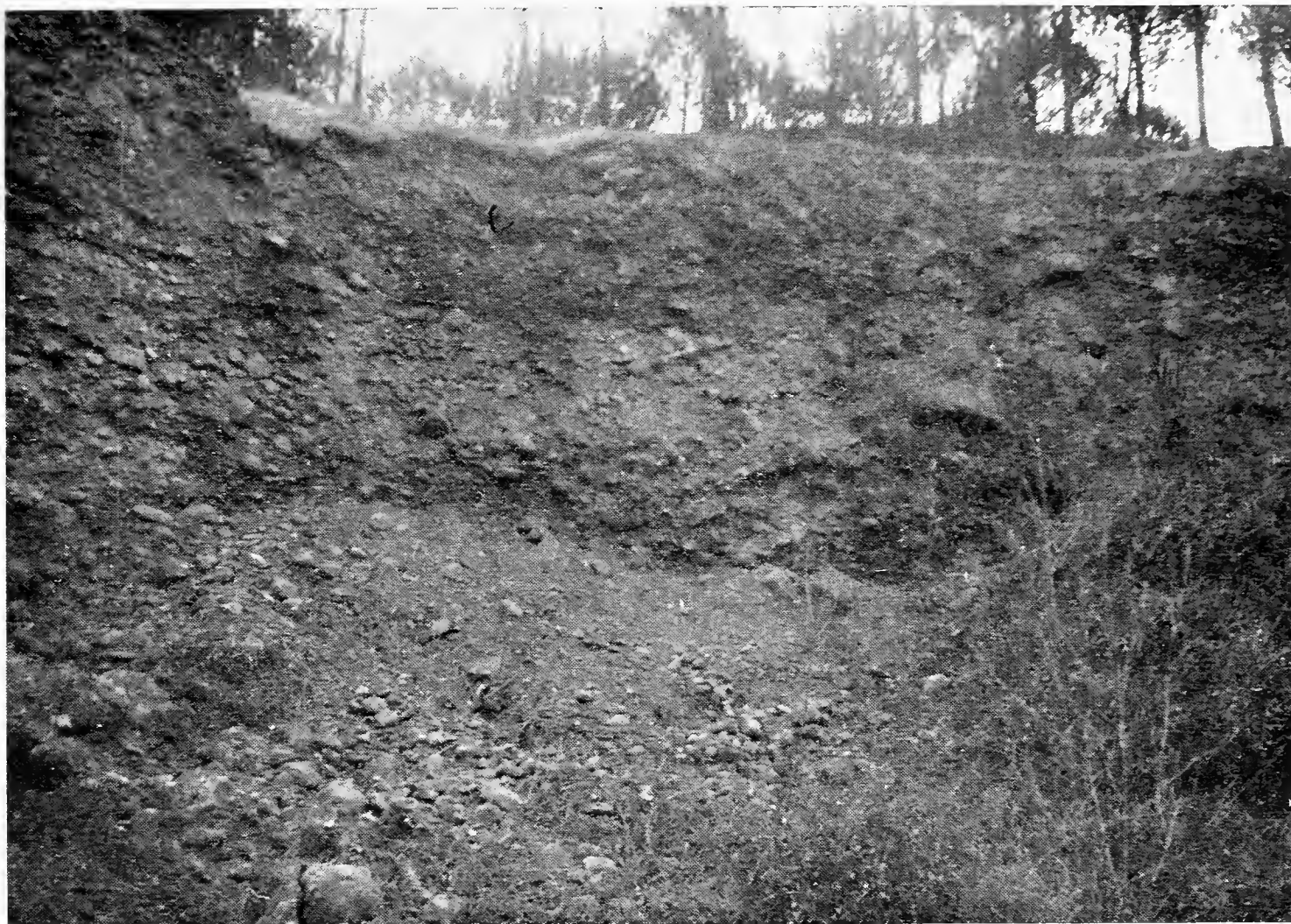
Fig. 11. — Cava la Palazzaccia (Santa Lucia). Il fronte di cava, tutto nella formazione ghiaiosa, misura 15 m di dislivello.
