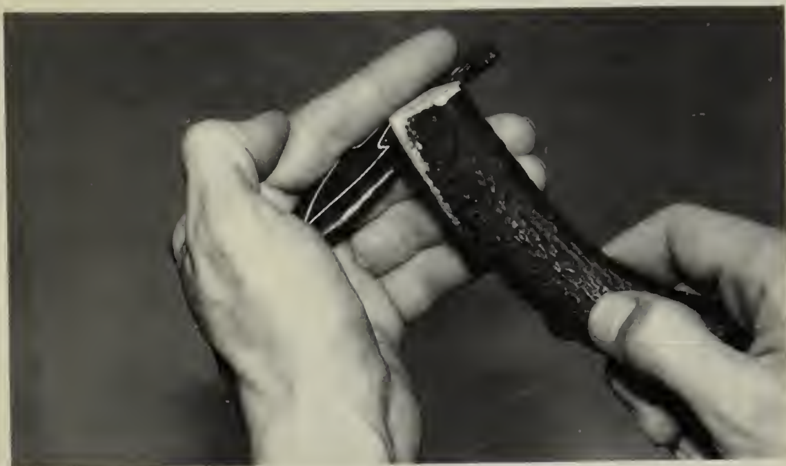
Fig. 21 – Realizzazione di una cuspidi a sezione biconvessa: prima sgrossatura a percussione diretta.
