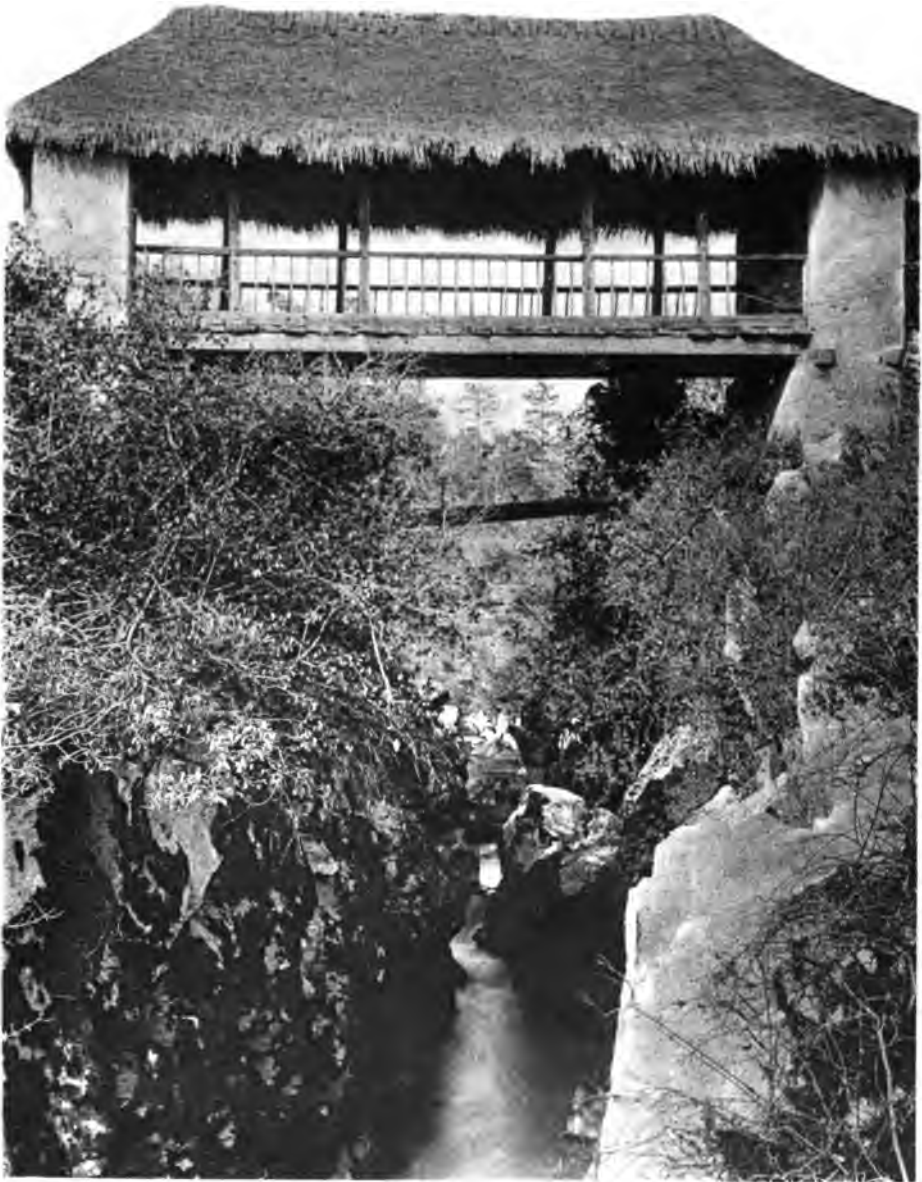
Brücke bei El Verjel
