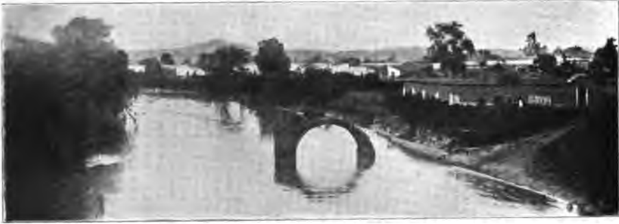
Alter Brückenbogen bei Acámbaro
