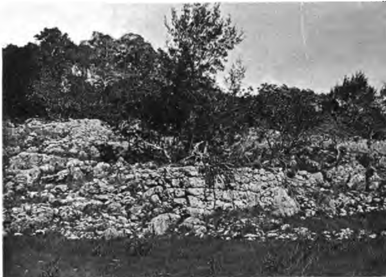
Mauer im Patio der alten Stadt
