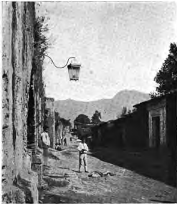
Vorstadtstrasse bei der Wasserleitung
