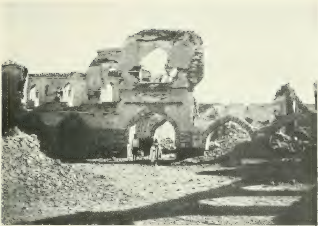
Mokka — Ruinen eines großen Palastes
