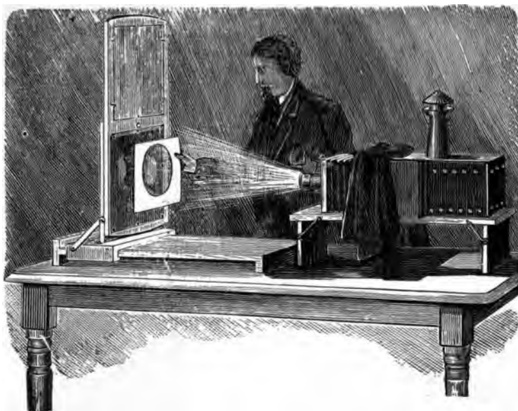
Fig. 204. Herstellung von Vergrößerungen bei künstlichem Licht.
