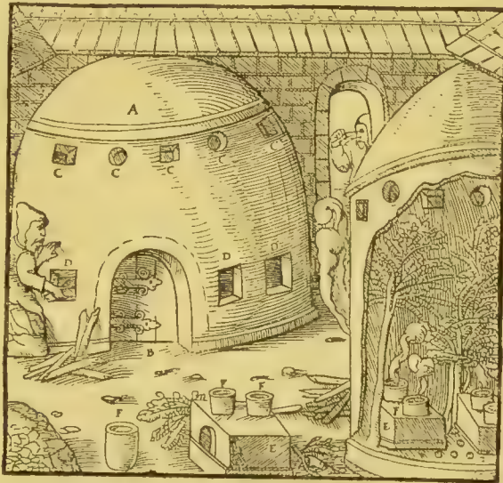
Fig. 41. Ofen zur Quecksilbergewinnung durch Sublimierung nach einem Holzschnitte vom Jahre 1557.
