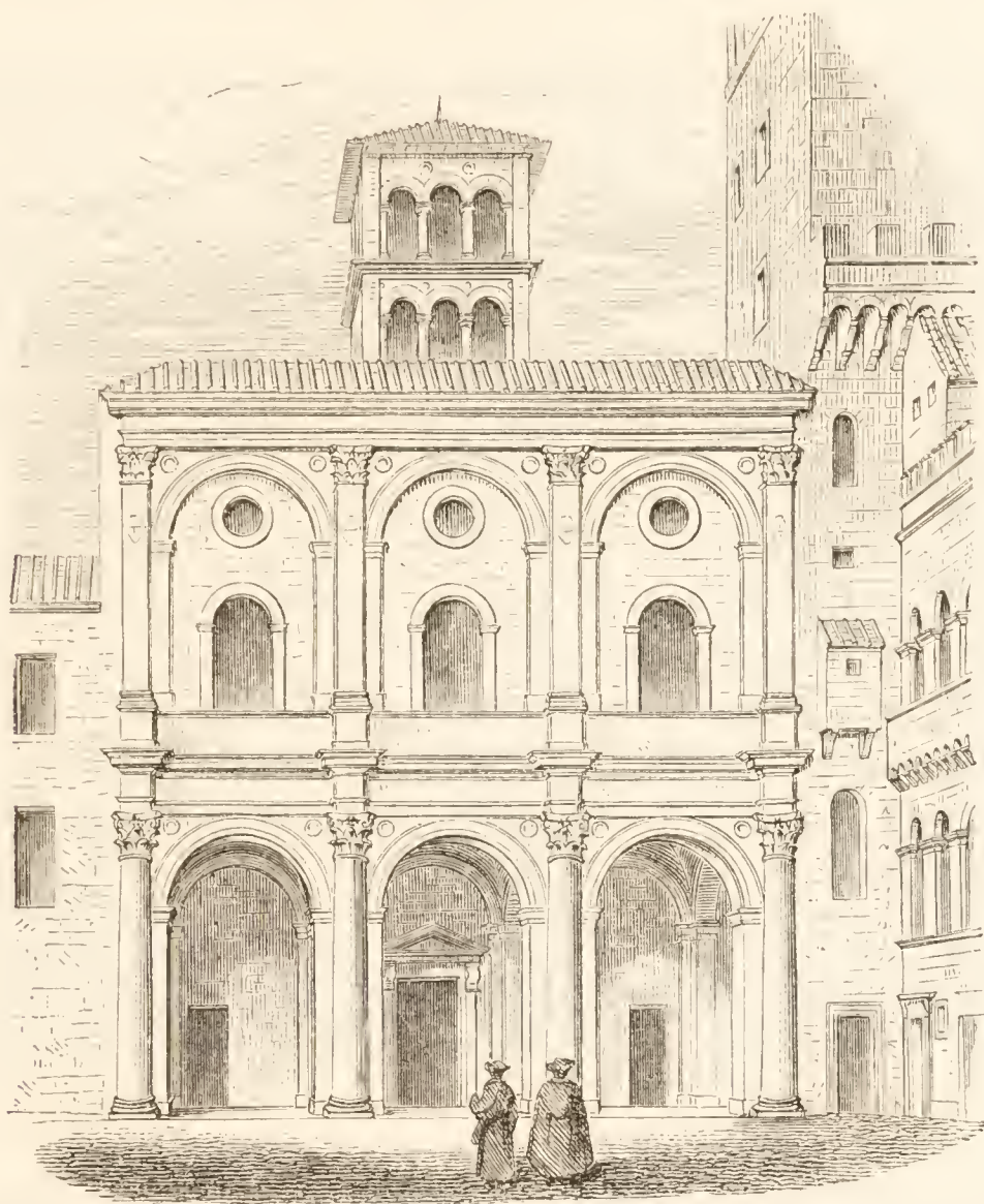
Fig. 107. Fassade von S. Marco in Rom.
