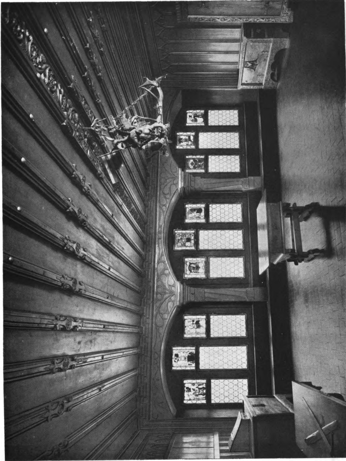
Mellingen (Kt. Aargau). — Ehemalige Ratsstube, 1467. Fensterwand (Bf. = 8,45 × 8,08 m; H. = 3,03 m) Inschrift am mittleren Deckenbalken: „uli hans widerker, werchmeister dieser stat, anno domini MCCCCLXVII (1467). Der nit hat pfennig noch pfand der ess der truben ab der wt(n)d.“ Jetzt im Schweizer Landesmuseum, Zürich
