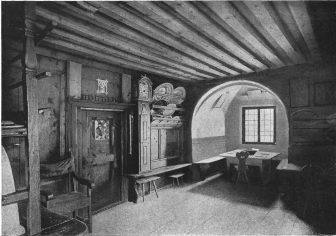
Pradill bei Villanders (Südtirol). — Stube des Pfliegerhauses Gotische Tramdecke aus der zweiten Hälfte des 16. Jahrh.
