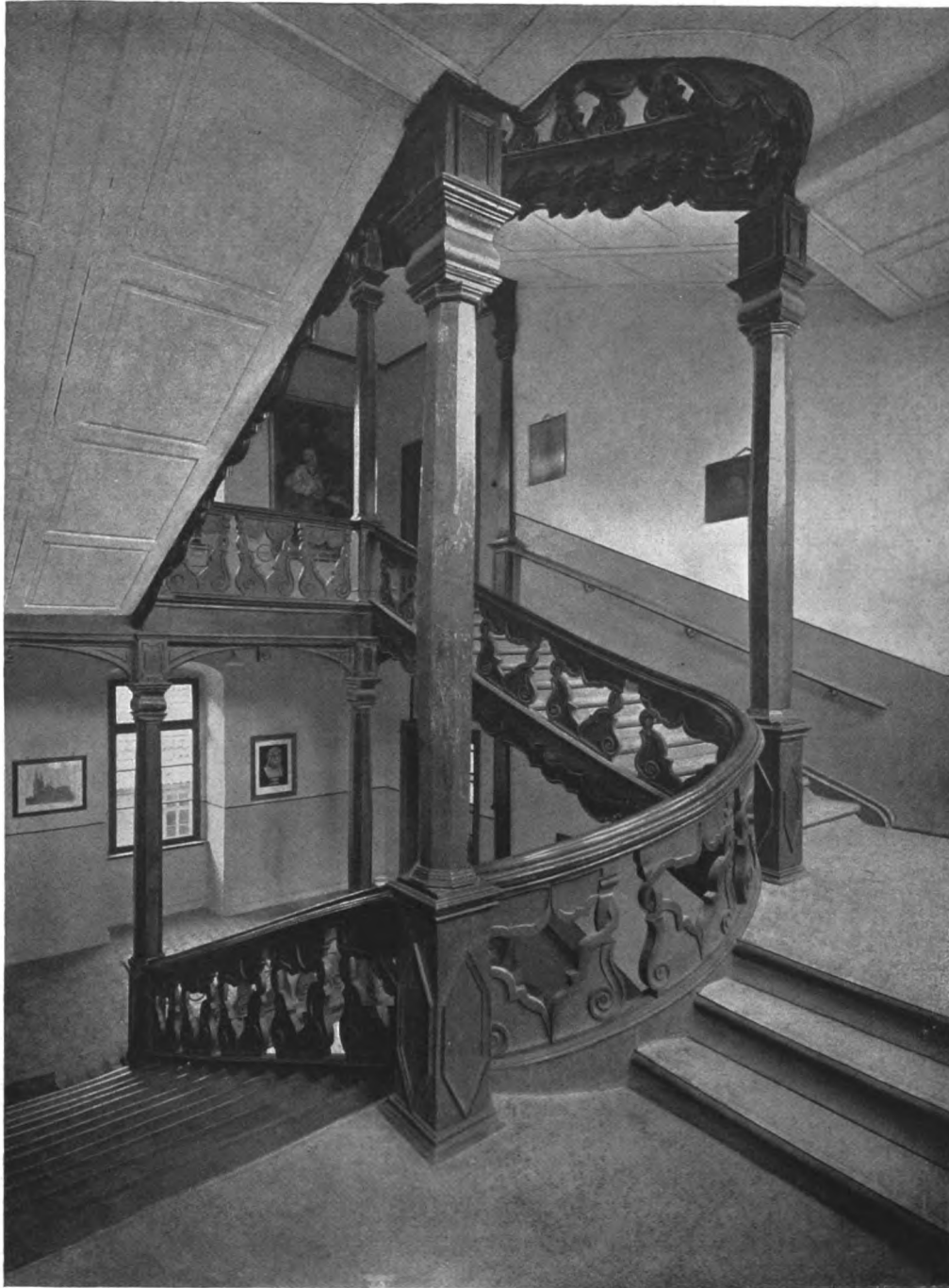
Heiligenstadt (Prov. Sachsen). — Treppenhaus im Gymnasium, früherem Jesuitenkolleg Erbaut um 1740. Die Säulen der ursprünglich freitragenden Treppe sind zwischen 1830 und 1840 eingefügt worden
