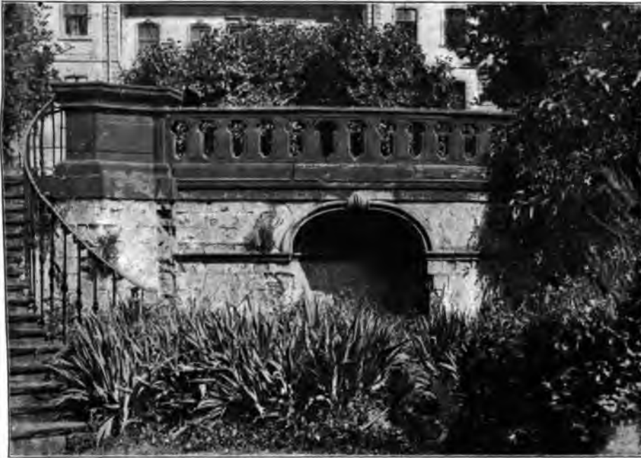
Fig. 40. Höchst. Bolongaro-Palast. Gartenterrasse.
