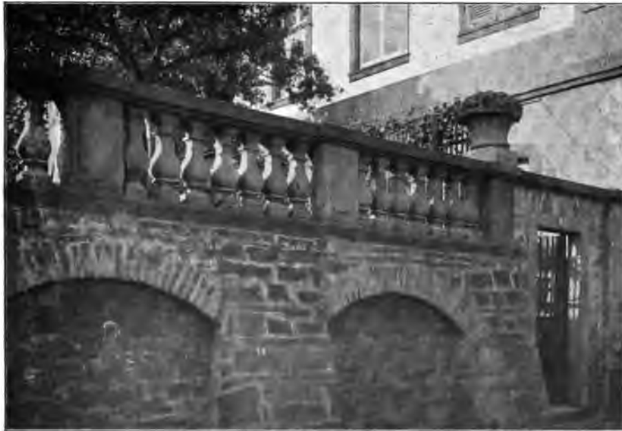
Fig. 41. Höchst. Bolongaro-Palast. Terrassenmauer nach dem Main.
