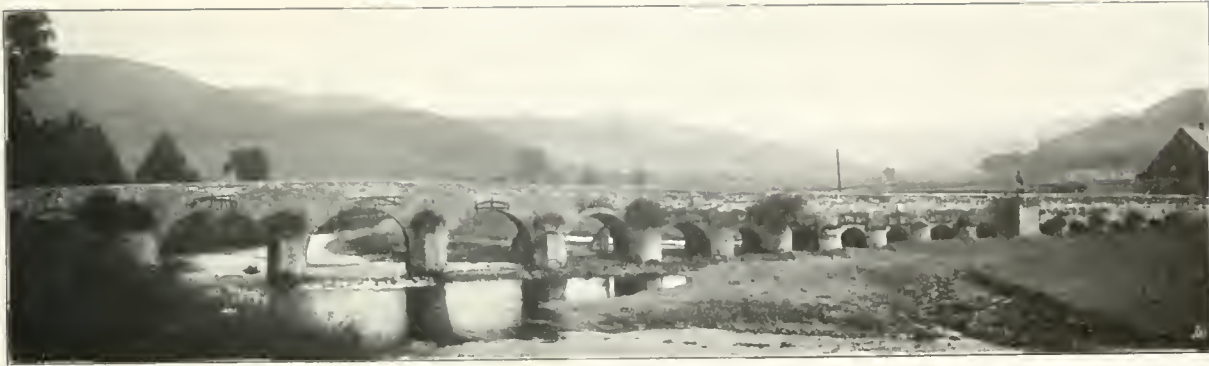
Alte Brücke in Grevenbrück.
