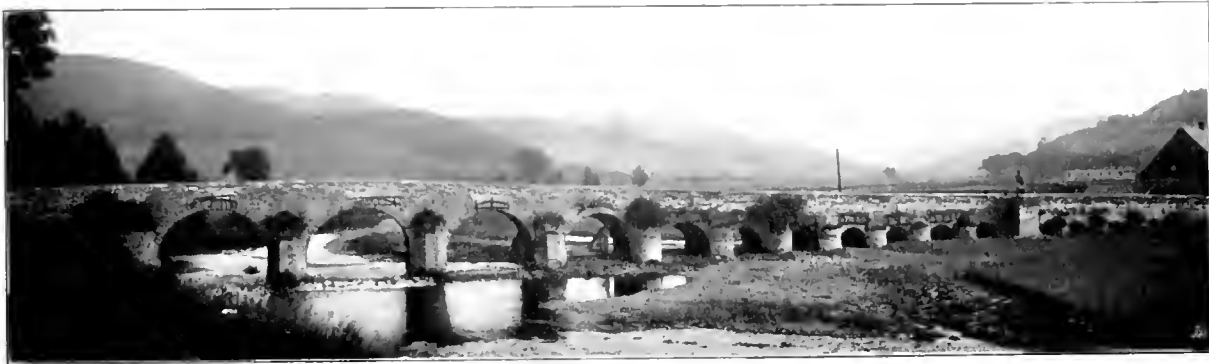
Alte Brücke in Grevenbrück.
