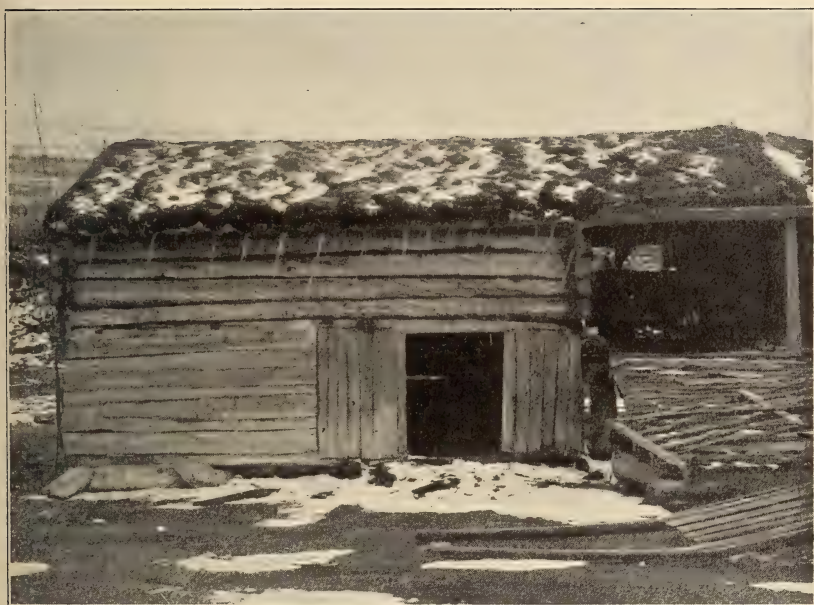
Fig. 1. Laavebygning paa Inset, Bardø, med istapper fra takskjegget. 24 mai 1910.
