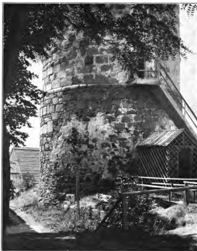
Fig. 91. Thannstein. Mauerwerk des Bergfrieds der Burgruine.
