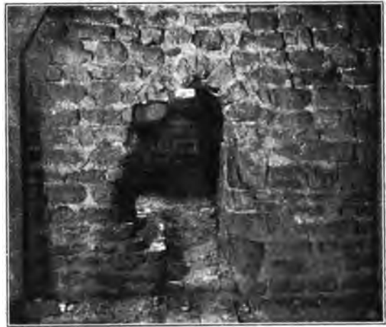
Fig. 39. Neunburg v. W. Romanisches Mauerwerk, außen an der Westwand des Turmes von St. Jakob im Dachboden des Langhauses.
