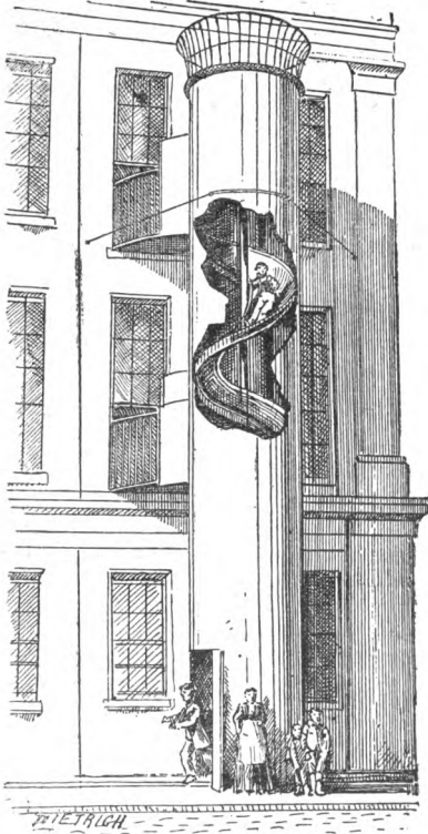
Rettungsturm an Gebäuden für den Fall eines Brandes.
