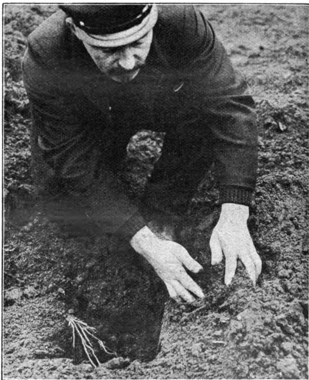
Die Zuschüttung der Pflanzlöcher.
