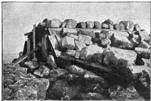
Belastung des Bohlengerüsts auf einer im Bau begriffenen Bühne vor Eintritt der Flut.
