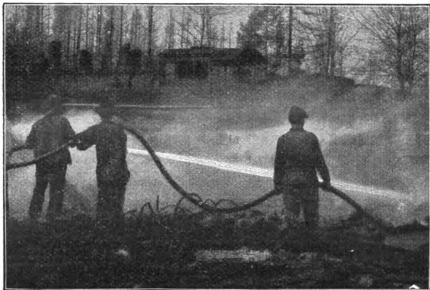
Löschversuche mit Hilfe von Wasser, das in einem Eisenbahnzuge herangeschafft wurde.
