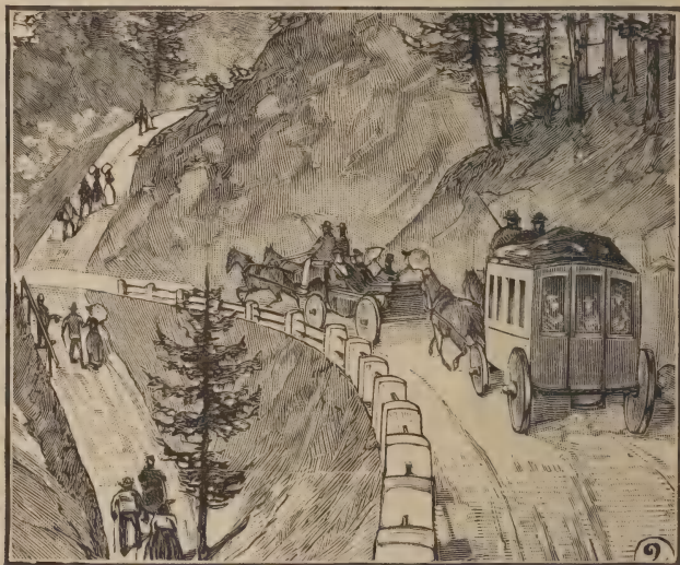
Partie von der alten und neuen Straße über den Ettaler Berg.
