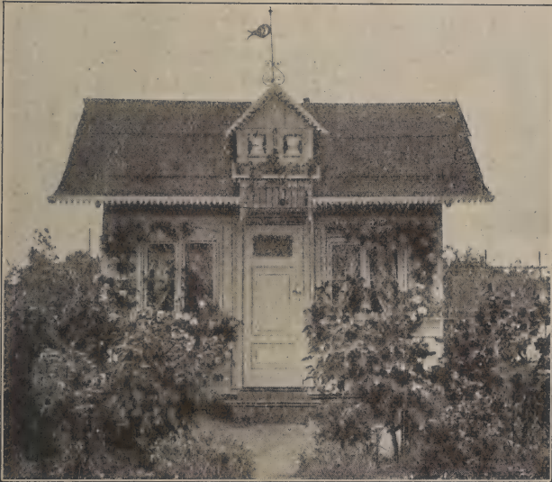
Abb. 5. Abschreckendes Beispiel: Wie eine Wohnlaube nicht errichtet werden soll.
