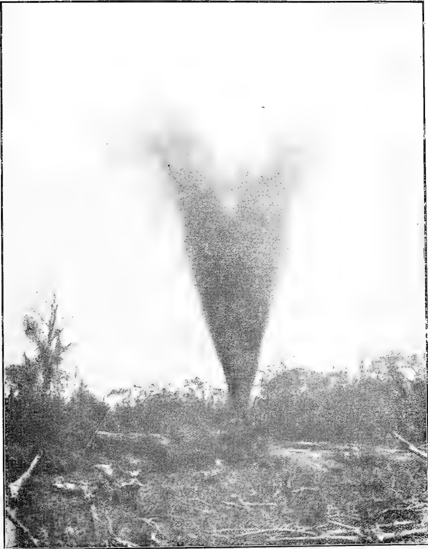
Gran Pozo Brotante de Petróleo del Llano Núm. 4. Profundidad de la perforación, 587 metros. Presión de los gases, 40 kilogramos por centímetro cuadrado. Potencialidad de la producción en petróleo, 16,666 toneladas diarias.
