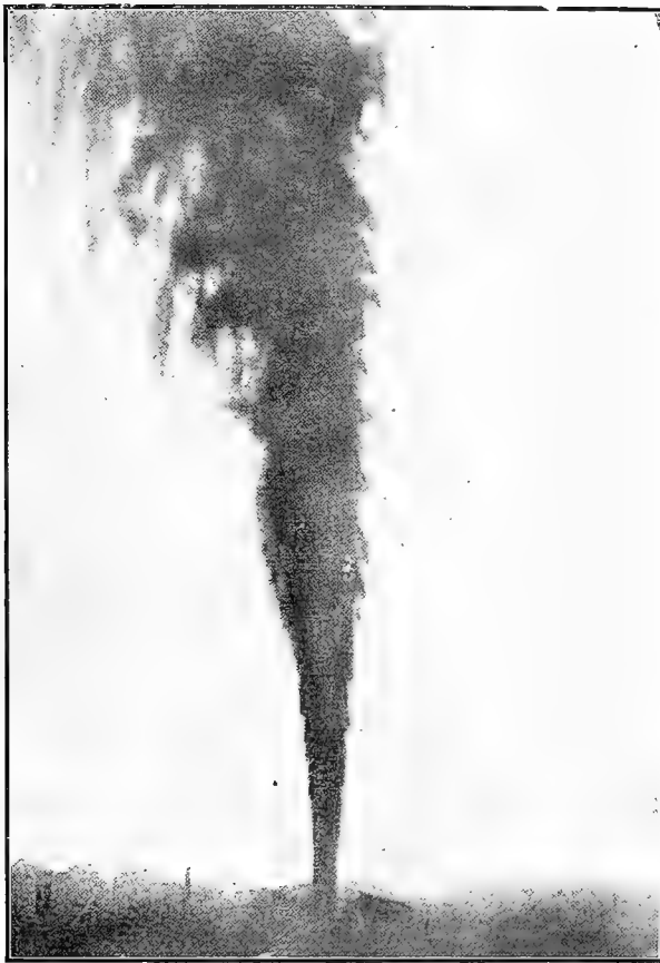
Gran Pozo Brotante de Cerro Azul Núm. 4. Profundidad de la perforación, cerca de 820 metros. Presión de los gases, 70 kilogramos por centímetro cuadrado. Potencialidad de la producción en petróleo, 37,576 toneladas diarias.
