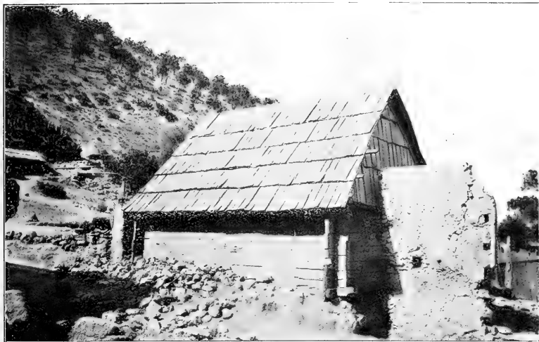
Fotografía número 1.—Casa de madera perfectamente conservada después del terremoto. Saltillo Lafragua.
