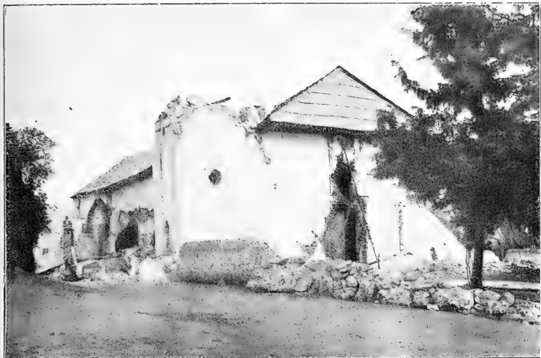
Fotografía número 1.—Iglesia de Chilchotla, Pue. Fachada al W. Caída de la torre al NE.
