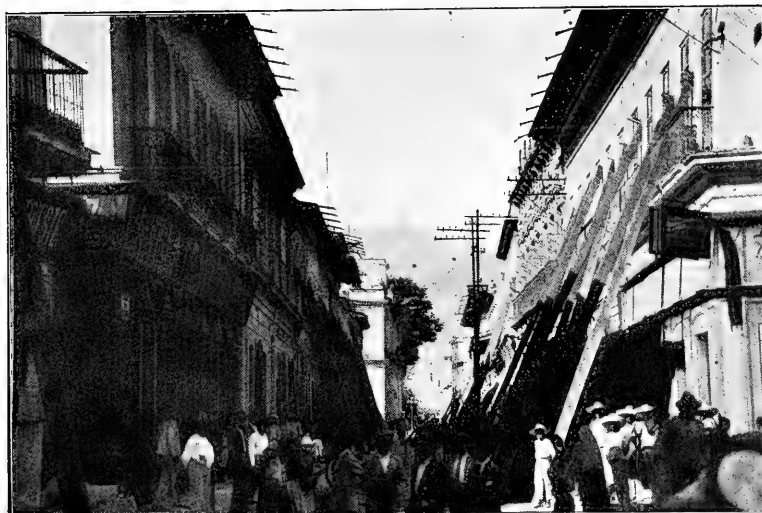
Fotografía número 2.—Jalapa, Ver. Casas apuntaladas en la calle de Enriquez. En el fondo se ve la cima del Cofre de Perote.
