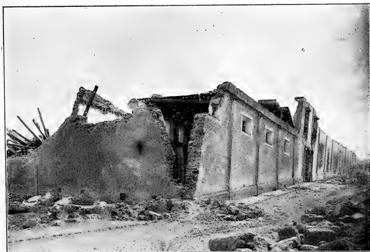
Fotografía número 2.—Casa del señor Rojí en Saltillo Lafragua. Fachada al S. Esquina SW. arruinada. Interior en completa ruina.
