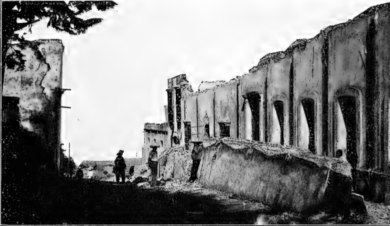
Fotografía número 1.—Caída de la cornisa de la fachada de la casa del señor Rojí al S., Saltillo Lafragua.
