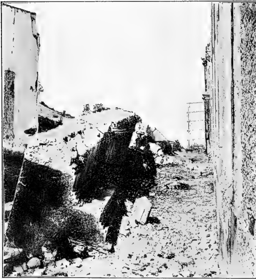
Fotografía número 2.—Detalle de la cornisa: altura, 1.50; espesor medio, 0.63; longitud, 18.00 metros. Distancia del centro de gravedad del block caído al muro, 1.70. Altura del muro, 5.00 metros.
