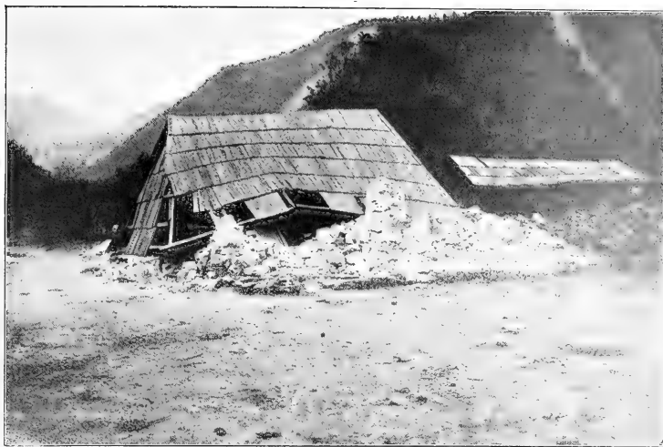
Fotografía número 1.—Habitación destruída en la esquina SW. de la plaza de Patlanalá, Pue.
