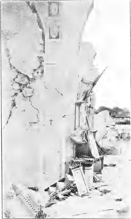
Fotografía número 1.—Pilar cuartecado del templo de Cosautlán, Ver.
