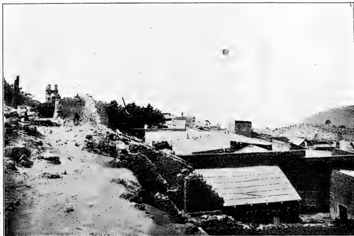
Fotografía número 1.—Calle de Saltillo Lafragua, orientada de E. a W. y un conjunto de construcciones "en retaje" que sufrieron menos que las edificadas en las laderas.
