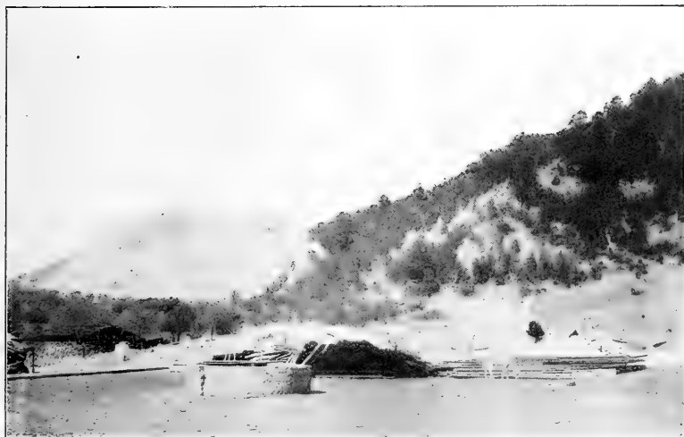
Fotografía número 2.—Plaza de Chilchotla, Pue. A la derecha, ruinas de la Casa Municipal. Efectos de los derrumbes en las montañas que circundan la población. (Cámara al SW.)
