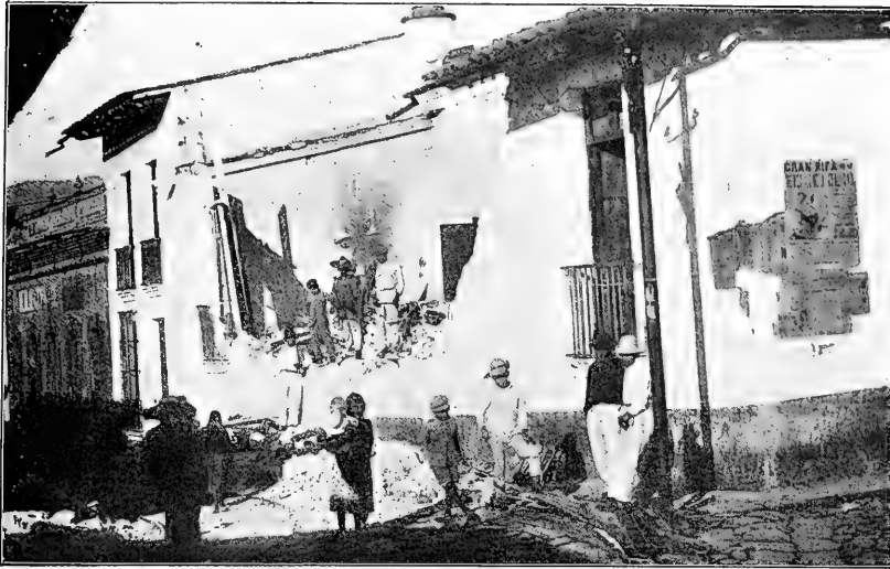
Fotografía número 1.—Casa destruida en la 4. a de Allende, Jalapa, Ver.
