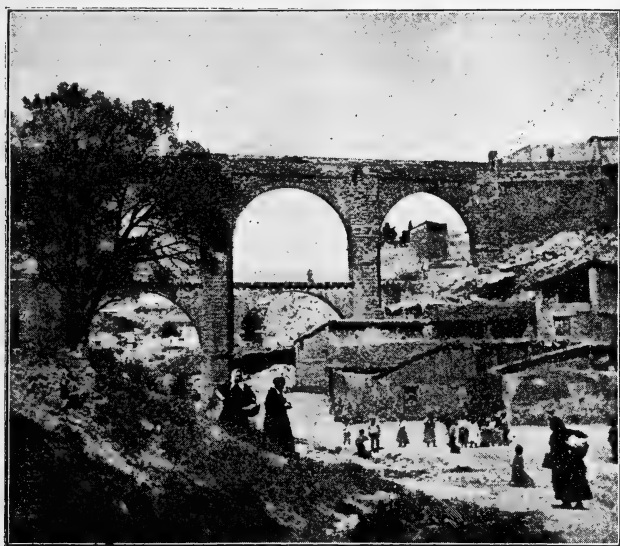
Fig. 5. a ACUEDUCTO DE TERUEL
