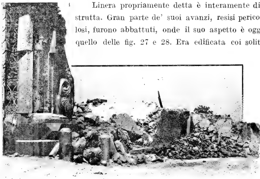
Fig. 27. — Linera, dopo le demolizioni.
