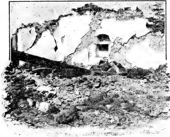
Fig. 28. — Casa di Linera, dopo la demolizione.
