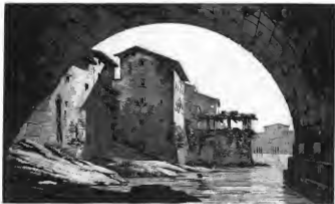
VEDUTA AL DI SOTTO DEL PONTE NOTTO.
