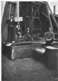
Fig. 3. Das Erdöl fließt aus der Pumpe in beständigem Strahl in einen Tank.
