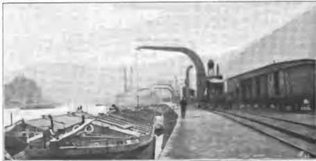
Abb. 221. Dampfkrahn auf dem Umschlagplatz in Aussig a. d. Elbe.
