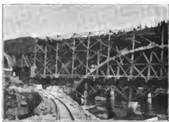
Abb. 133b. Pruthbrücke bei Jaremcze im Bau. [Erste Steinschar.]
