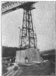
Abb. 106. Reconstruction der Iglawa-Brücke. [Auswechslung der Gussstahnpfeiler.]
