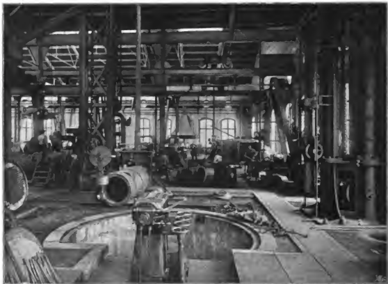
Abb. 369. Werkstätte Linz der k. k. österreichischen Staatsbahnen. [Kesselschmiede und Blechbearbeitungswerkstätte, im Vordergrund fixe hydraulische Nietmaschine.]
