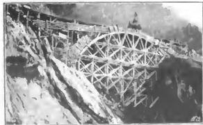
Abb. 127 a. Wäldlitobelbrücke im Bau. [Arbergbahn.]
