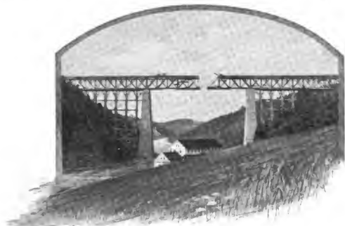
Abb. 150 a. Moldaubrücke bei Červená [im Bau].
