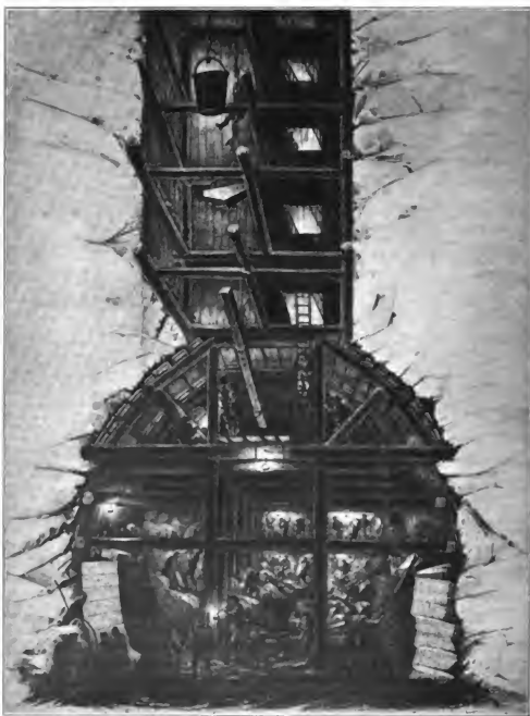
Abb. 90. Bau des alten Pressburger Tunnels. [Nach einem Original im Privatbesitze des Ingenieurs J. Deutsch, Pressburg.]
