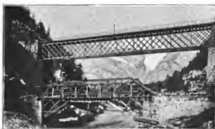
Abb. 140. Gitterbrücke bei Kastenreith, [Kronprinz Rudolf-Bahn.]
