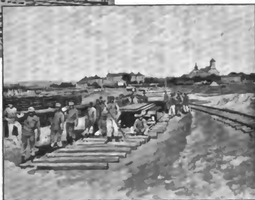
Legung des Oberbaues.
