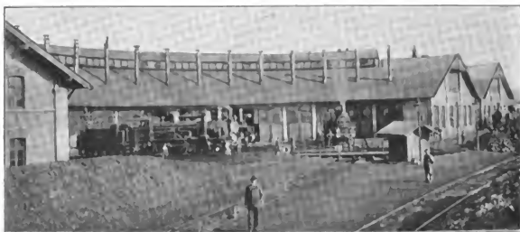
Abb. 402. Heizhausanlage [rotundenförmige] auf dem Franz Josef-Bahnhof in Wien. [Nach einer Original-Aufnahme von A. Stempf.]
