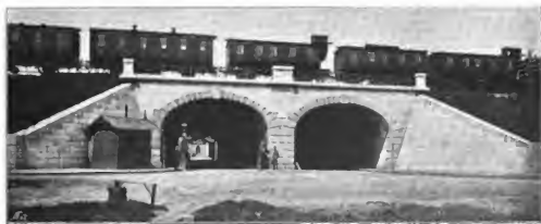
Abb. 134. Gewölbe Durchfahrt aus Stampfbeton auf dem Brüner Nordbahnhof. [Kaiser Ferdinands-Nordbahn.]
