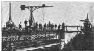
Abb. 108. Verstärkung der Trassbrücke in St. Pölten.
