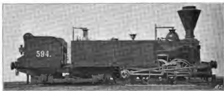
Abb. 241. Engerth- Locomotive der südlichen Staatsbahn. [1866.]
