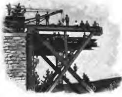
Abb. 159 b. Montirung der Moldaubrücke bei Cervena.
