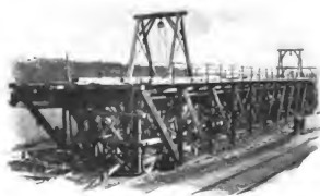
Abb. 170 Auswechslung des Viaducts bei Stranov.
