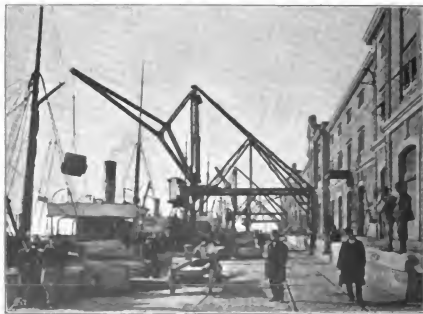
Abb. 225. Hydraulische Fahrkrane auf den Molos in Triest.
