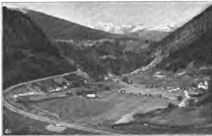
Abb. 48. Kehrschleife der Brenner-Bahn im Pfierschtale.
