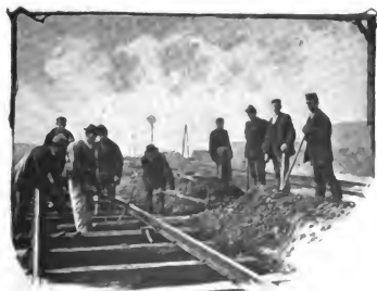
Abb. 112c. Schwellen-Auswechslung auf der Strecke. [Nach Momentaufnahmen von J. Schneemann.]
