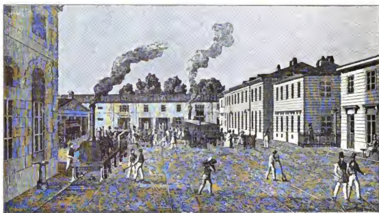
Abb. 179. Innere Ansicht des Bahnhofes der k. k. ausschl. priv. Kaiser Ferdinands-Nordbahn zu Wien. [Nach einem Original aus dem Jahre 1858.]
