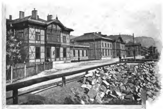
Abb. 269. Aufnahmegebäude und Restaurationsgebäude Kufstein [Südbahn].
