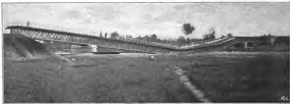
Abb. 10. Eisenbahnbrücke über die Weichsel [Strecke Oswiecin-Myslowitz] nach der am 23. Juni 1866 erfolgten Sprengung.
