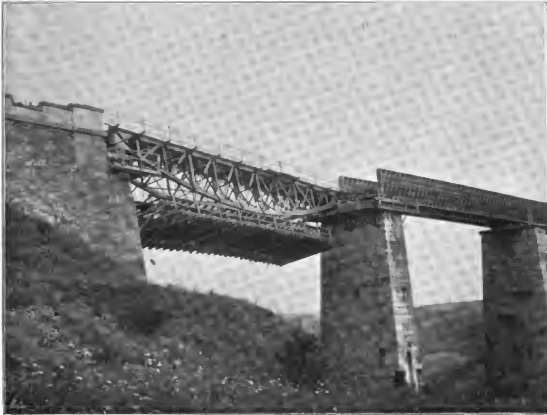
Abb. 144. Schiffkornbrücke. [Klabawa-Viaduct bei Chrást während der Auswechslung 1892] [Nach einer photographischen Aufnahme von F. Dworák in Pilsen.]
