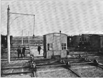
Abb. 383. Wagenschlebeebühne mit elektrischem Antrieb.
