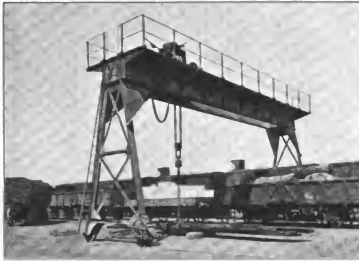
Abb. 201. Krah für schwere Lasten auf dem Frachtenbahnhof Matzleinsdorf.
