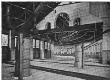
Abb. 403. Inneres eines Rotunden-Heizhauses.
