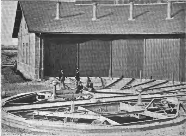
Abb. 400. Locomotiv-Drehscheibe auf dem Wiener Nordwestbahnhofe.
