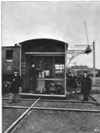
Abb. 382. Motorhäuschen der elektrisch betriebenen S. bleibühne.
