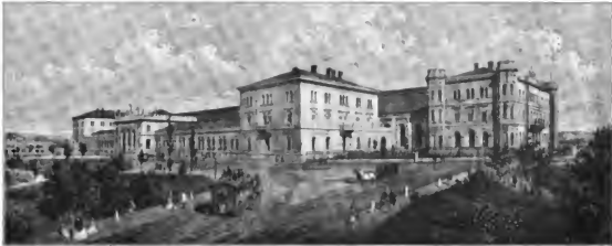
Abb. 250. Ansicht des Wiener Aufnahmegebäudes der Kaiserin Elisabeth-Bahn. [1869.]
