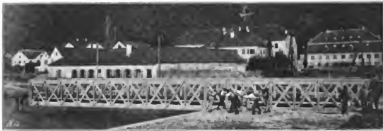
Abb. 164. Eisenbahn-Drehbrücke Bregenz. [Linie Bregenz-Lindau.]
