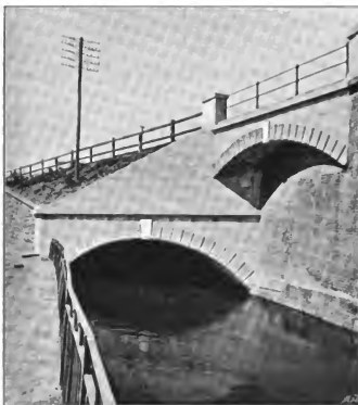
Abb. 136. Durchlass aus Stampfbeton auf dem Brüner Nordbahnhofe.
