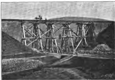
Abb. 21. Eisenbahn-Viaduct der Nordbahn bei Hollnec nach der am 14. Juli 1866 erfolgten Sprengung, mit dem von den preussischen Truppen hergestellten Provisorium. [Nach einer Photographie aus dem historischen Museum der k. k. Staatsbahn.]
