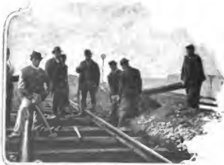
Abb 112b. Schwellen-Auswechslung auf der Strecke. [Nach Momentaufnahmen von J. Schneemann.]
