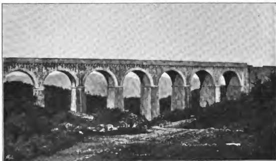
Abb. 125. Viaduct der k. k. südlichen Staatsbahn über die alte Triester Strasse bei Laibach, [1896.]
