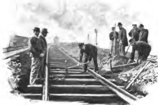
Abb 112a. Schwellen-Auswechslung auf der Strecke. [Nach Momentaufnahmen von J. Schneemann.]
