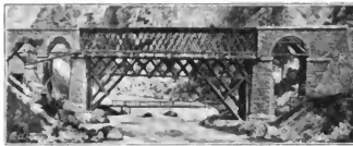
Abb. 17. Gitterbrücke über die Enns. [Kronprinz Rudolf-Bahn, Gekäuse-Eingang.]
