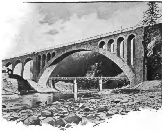
Abb. 133a. Brücke bei Jarencze. [K. k. Staatsbahn Stanislau-Woronienska]
