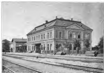
Abb. 270. Bahnhof Zauchtl. [Nordbahn.] [1861.]
