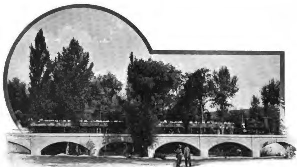
Abb. 135 Viaduct aus Stampfbeton bei Pohrlitz. [Kaiser Ferdinands-Nordbahn]
