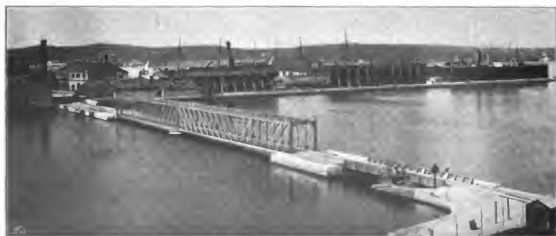
Abb. 163 Eiserne Verbindungsbahn zwischen dem Festlande und der Oliven-Insel im Kriegshafen Pola mit Drehbrücke.
