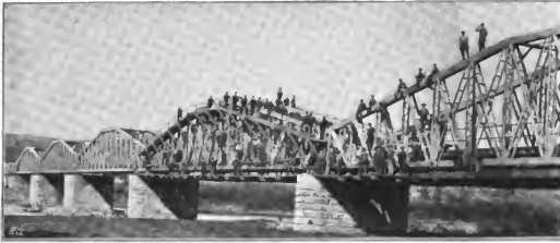
Abb. 145. Reconstruction der Dniesterbrücke bei Niznów. [Stanislaw-Hustiatyn.]
