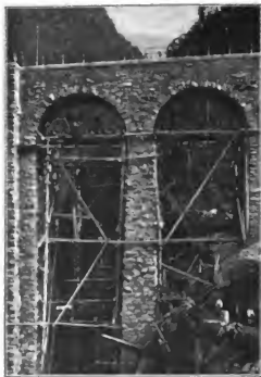
Abb. 128. Trisana-Viaduct. [Pfeilerbau.] [Nach einer photographischen Aufnahme von J. Gatzna, Innsbruck.]
