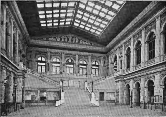
Abb. 208. Vorhalle des neuen Wiener Südbahnhofes. [1875.]
