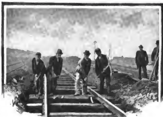
Abb. 112d. Schwellen-Auswechslung auf der Strecke [Nach Momentaufnahmen von J. Schneemann.]
