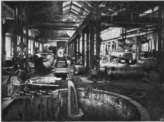
Abb. 368. Werkstätte Linz der k. k. österreichischen Staatsbahnen, [Kesselschmiede, im Vordergrund Seitenansicht der feststehenden hydraulischen Nietmaschine.]
