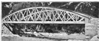
Abb. 149. Bogensegmentträger, Fella-Brücke. [Tartis-Pontafel.]
