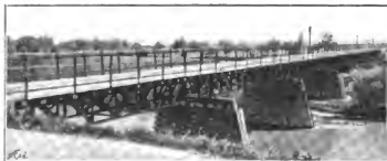
Abb. 107. Brücke über den Mitterbach. [Schwochat-Mannsdorf.]
