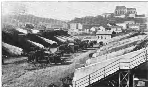
Abb. 218. Kohlenbahnhof der Nordbahn in Brünn.
