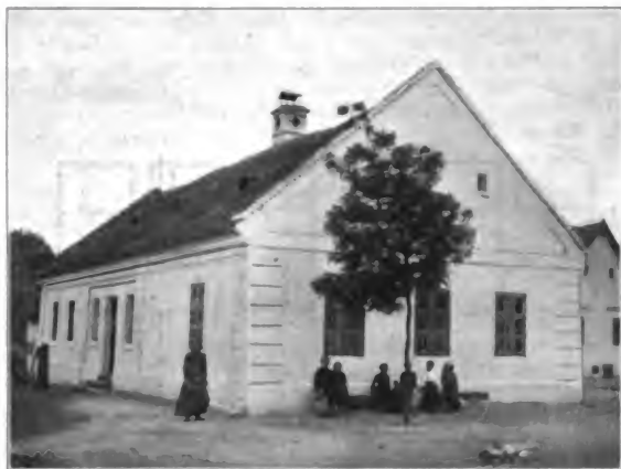
Fig. 36. Wohnhaus in Órvényes.
