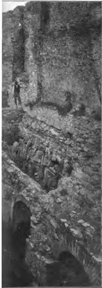
thalle und der darüber liegenden Kapelle.
