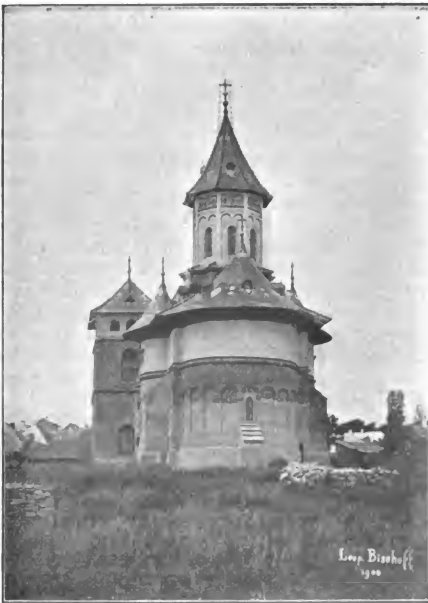
Fig. 11. Mirouzkirche in Sucezawa nach der Restaurierung.
