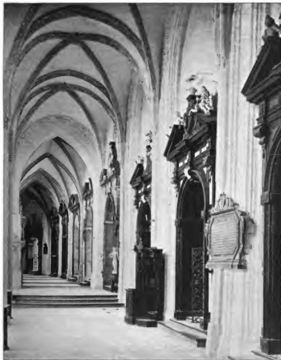
Abb. 77. Dom in Gnesen. Blick in das südliche Seitenschiff.
