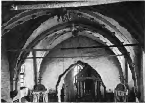
Abb. 115. Gewölbe der S. Johannes-Kirche in Gnesen.
