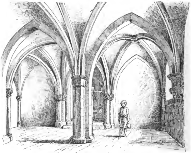
Sogenannte Krypta im ehemaligen Schlosse zu Stadtilm.
