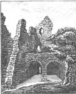
Innen-Ansicht der Rothenburg.
