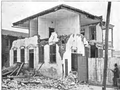
Erdbeben von Charleston 1886. 167 Traddstreet. Die Bewegung war nach SO. gerichtet.
