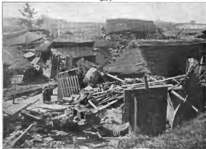
Erdbeben in Zentral-Japan, 1891 Oktober. Zerstörung der Gebäude.
