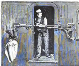
Myers' Automat zur Postabfertigung an fahrenden Zügen: Der am Wagen angebrachte Apparat.
