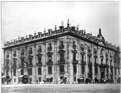
Abb. 231 Aduana-Zollgebäude in Valencia
