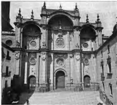
Abb. 80 Kathedrale in Granada Fassade
