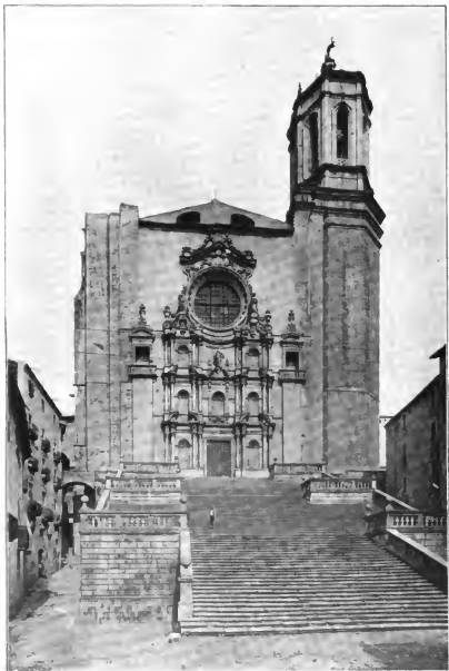
Abb. 181 Kathedrale in Gerona Westseite (Nach Uhde)
