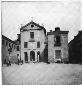
Abb. 57 La Encarnación in Madrid Fassade
