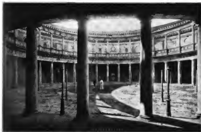
Abb. 12 Palast Karls V. auf der Alhambra in Granada Hof (Nach Jungbaendel-Gurlitt)
