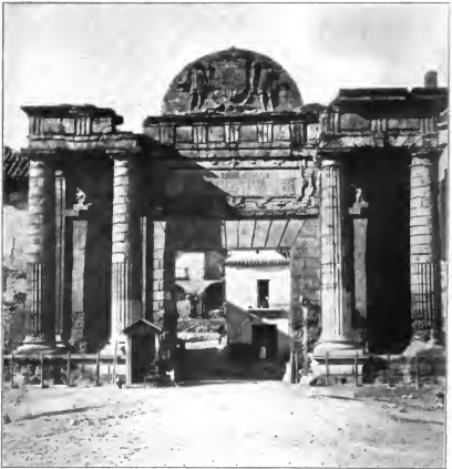
Abb. 44 Puerta del Puente in Cordoba
