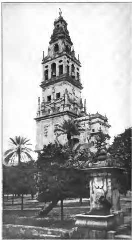
Abb. 144 Turm der Kathedrale in Córdoba
