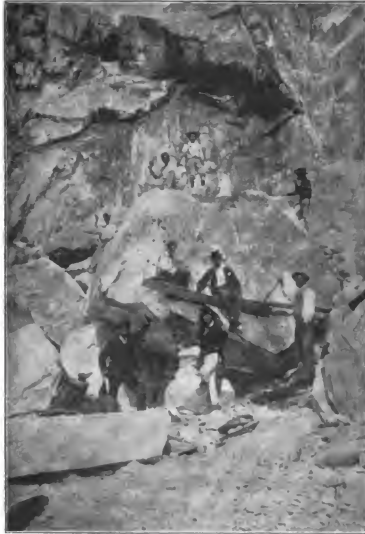
Losgesprengter Marmorblock.
