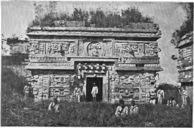
Fig. 3. Der Tempelpalast der Inschriften. Die Ostfacade des angebauten rechten Flügels. Unveröffentlichte Originalphotographie von Th. Maler.
