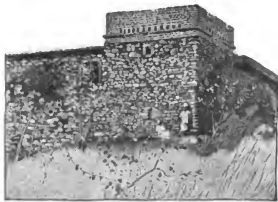
Fig. 13. Eckturm der Missionsmauern in Mpala.
