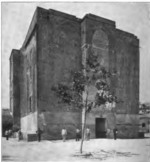
Abb. 23. La Cuba. Nordostseite.
