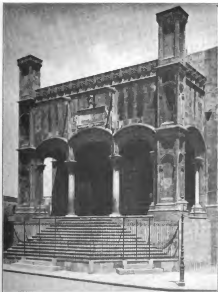
Abb. 91. Vorhalle von S. Maria della Catena. Palermo.
