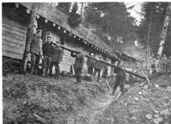
Bau eines Blockhauses auf „Schmittenhöhe“ in den Vogesen Nach Original-Aufnahmen
